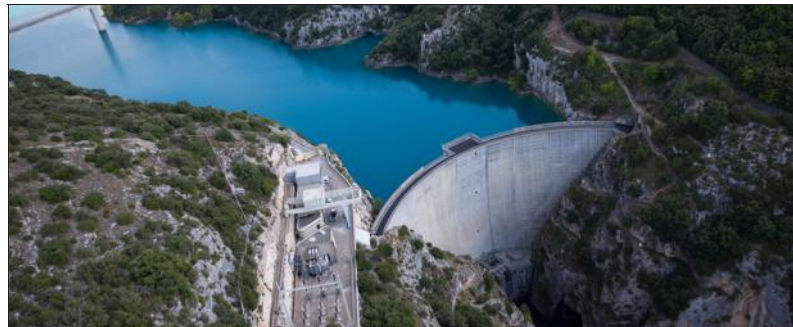
Le barrage de Sainte-Croix, une des installations hydrauliques EDF dans la zone des gorges du Verdon. Photo Franck ODDOUX
