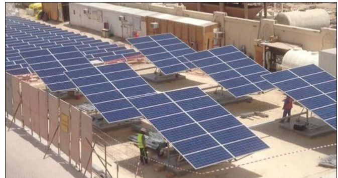
HeliosLite conçoit des trackers pour panneaux solaires qui s'orientent en temps réel en fonction de la course du soleil. DR
